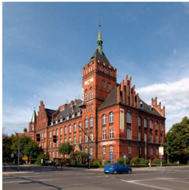
Gmach Wydziału Chemicznego Politechniki Śląskiej – stan aktualny.
