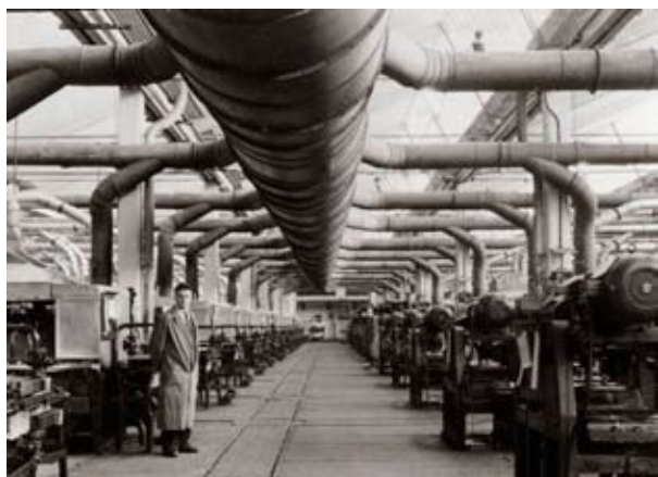
Hala fabryczna Zakładów Włókien Chemicznych w Tomaszowie Maz. (lata 20. XX w.) Foto ze zbiorów Zygmunta Dziedzińskiego
